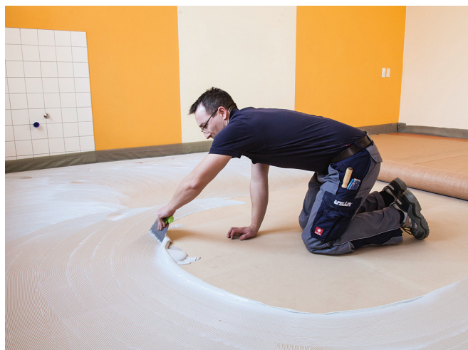
Verlegung von Linoleum auf UZIN RenoTop PLUS mit UZIN LE 44.
