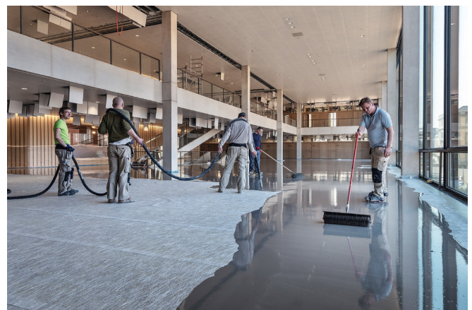
Überspachteln mit Hilfe von Pumptechnik von UZIN RR 201 mit UZIN NC 170 LevelStar.
